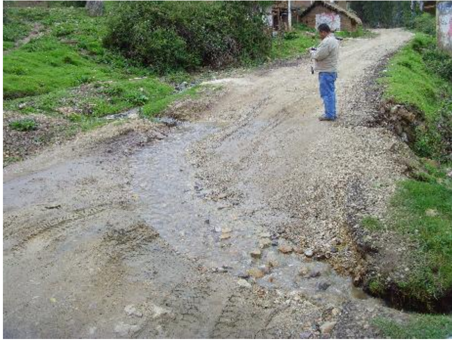
Foto N°03. -Se muestra la presencia de fluidos, que deterioran la Vía por falta de limpieza de Obras de Arte a la entrada del CP de Huampanan.
