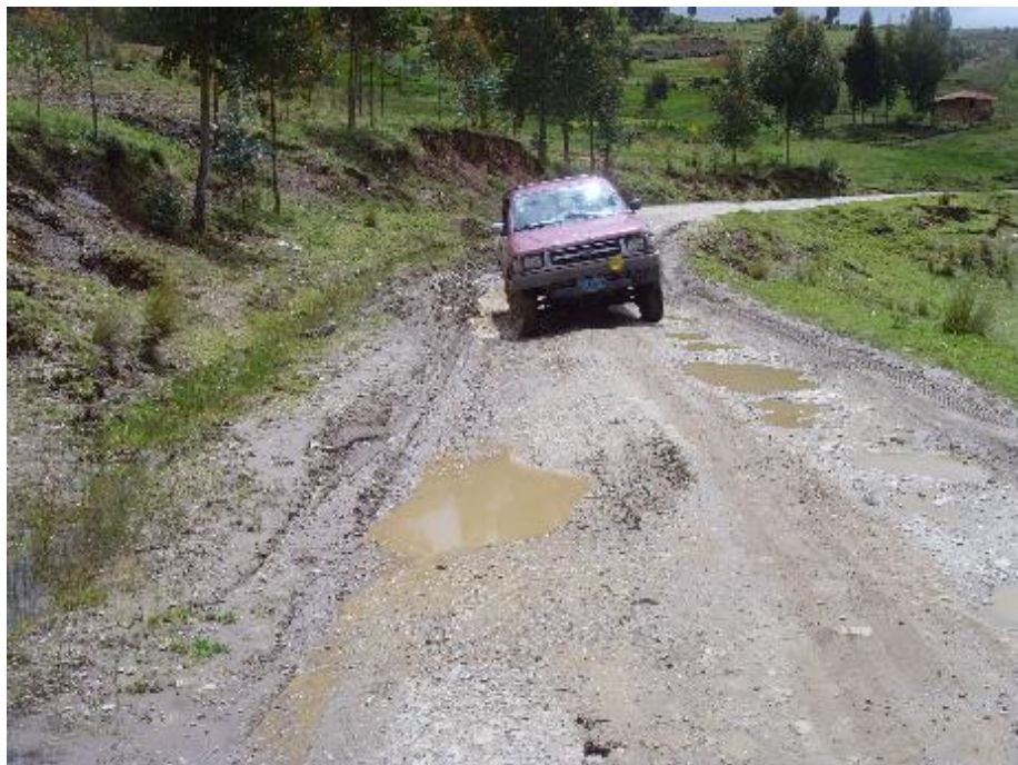
Foto N°02. -Se muestra la plataforma de la vía completamente erosionada por las constantes precipitaciones atmosféricas y la falta de un mantenimiento adecuado.
