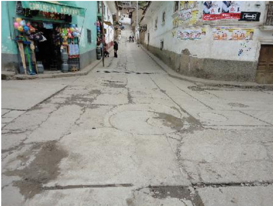
FOTO 04: Se muestra el área de trabajo y parte del pavimento rígido a reponer, se muestra además al lado izquierdo por donde cruza la tubería pvc de diámetro de 3".
