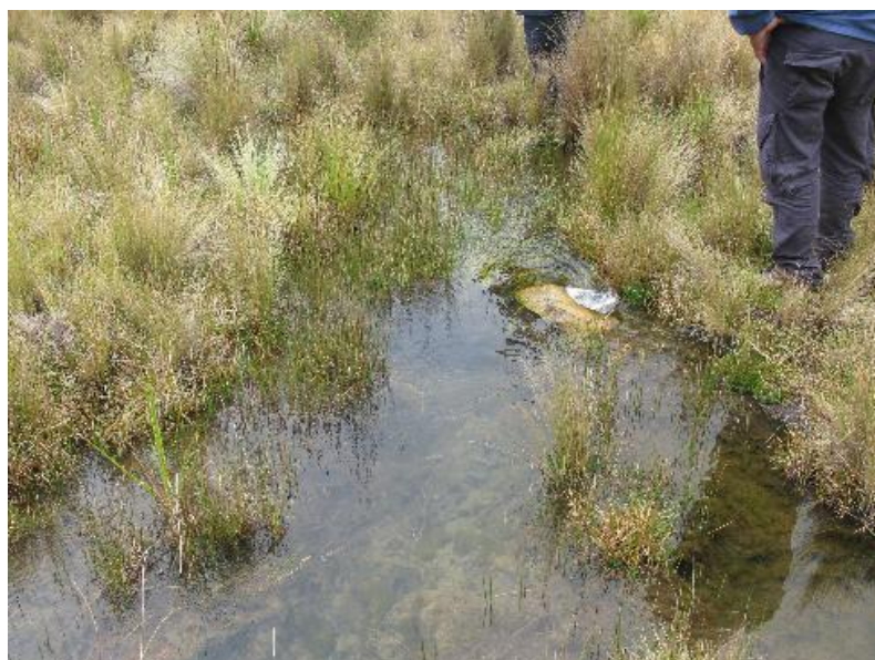
Foto 02: Vista actual donde se debería ubicar el filtro de grava, el cual no se aprecia y se denota la pérdida de carga del flujo.
