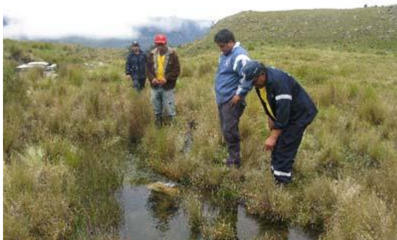
Foto 01: Vista de la ubicación de la Estructura de Captación en el sector denominado Tragón Cocha.
